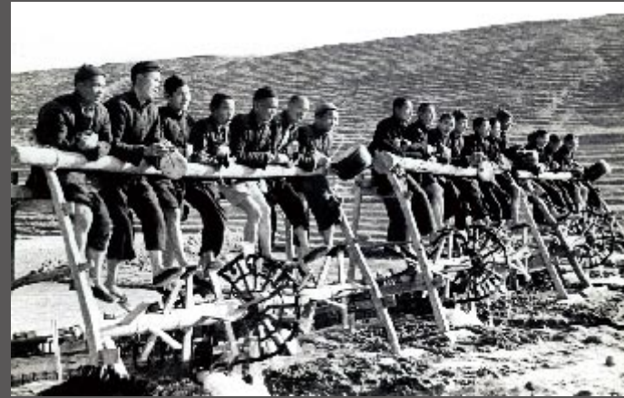
韓學章 攝 中國水利報 1963年2月，為治理淮河水患，人們在淮河支流洪河上修建分洪道，人們採用腳踏龍骨水車排水。
