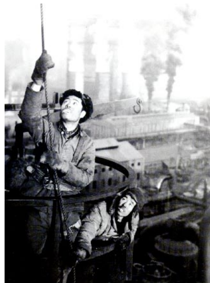
←●曉莊 攝影 ●江蘇人民出版社 1959年，江蘇省無錫市紅旗鋼鐵廠的土高爐出鐵。土高爐，大躍進時期的產物。農民用粘土和磚頭建造小高爐，拿家裡的鐵器作原料，用山上的木頭燒炭煉鋼。由於生產條件簡陋，生產出來的鋼材雜質多、氣泡大、結構強度低，沒有達到應用標準。大躍進期間很多農民將家中的鐵鍋、農具都貢獻出來，導致農業生產受到嚴重影響，同時大量植被被砍伐一空，也造成前所未有的生態災難！
