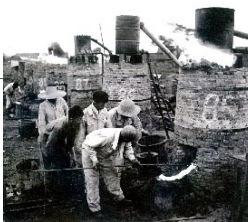
←●曉莊 攝影 ●江蘇人民出版社 1959年，江蘇省無錫市紅旗鋼鐵廠的土高爐出鐵。土高爐，大躍進時期的產物。農民用粘土和磚頭建造小高爐，拿家裡的鐵器作原料，用山上的木頭燒炭煉鋼。由於生產條件簡陋，生產出來的鋼材雜質多、氣泡大、結構強度低，沒有達到應用標準。大躍進期間很多農民將家中的鐵鍋、農具都貢獻出來，導致農業生產受到嚴重影響，同時大量植被被砍伐一空，也造成前所未有的生態災難！
