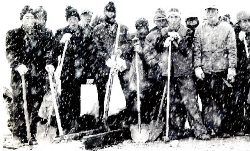
↑●盧廣 攝影 ●自由攝影師 2004年5月，風雪中的中鐵十八局青藏鐵路建設者們。青藏鐵路，北起青海省西寧市，南至西藏自治區拉薩市，全長約1956公里，是當今世界海拔最高、最長的高原鐵路。青藏鐵路於2006年7月全線通車，線路經過地區海拔4000公尺以上的地段有960公里，翻越唐古喇山線路最高處達5072米，號稱是離天堂最近的鐵路。
