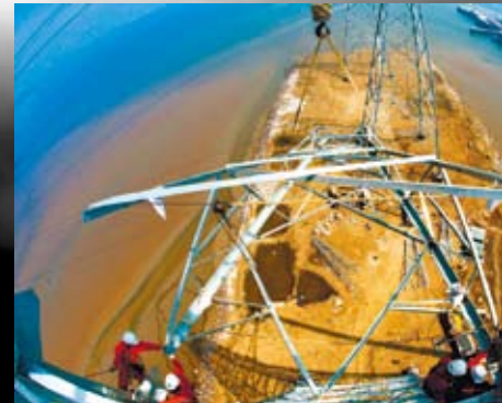
山東送變電工程公司施工人員對G3鐵塔的橫樑吊裝組立。工程建成投運後將大幅優化、改善電源佈局和電網結構，為環渤海經濟區的發展提供支撐。（新華社 田世超攝）
