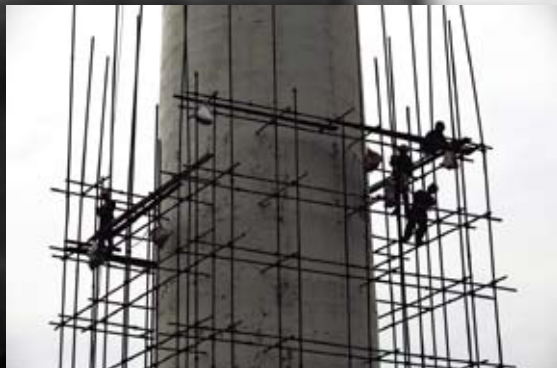
北京建四熱電中心助改善空氣品質。圖為工人們在搭建鷹架，準備拆除北京市豐台供暖所右安門外翠林鍋爐房的煙囪。（新華社金立旺攝）
