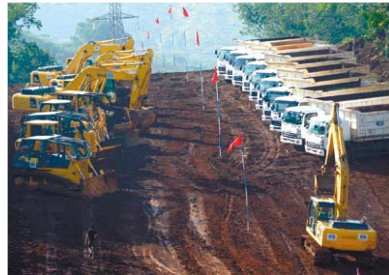
這是印尼西爪哇省瓦利尼拍攝的高速鐵路建築工地。(新華社阿貢攝)
