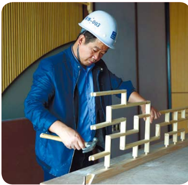
翟錫紅在長沙的一處專案工程建築內製作一套卯榫結構的木藝裝置。(新華社 李尢 攝)
