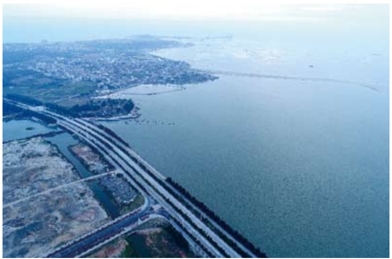
福建向金門供水工程輸水管道出海口晉江圍頭灣（無人機拍攝）。
