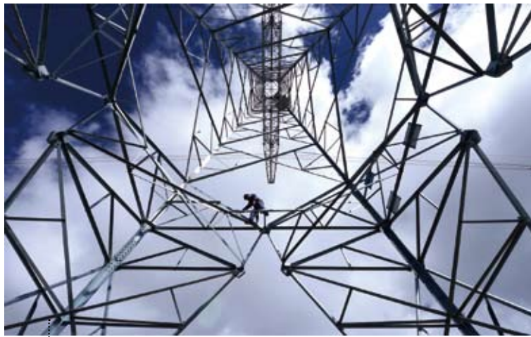
青海電力檢修公司工人在海拔4800公尺的崑崙山口一處輸電鐵塔上進行檢修工作。
