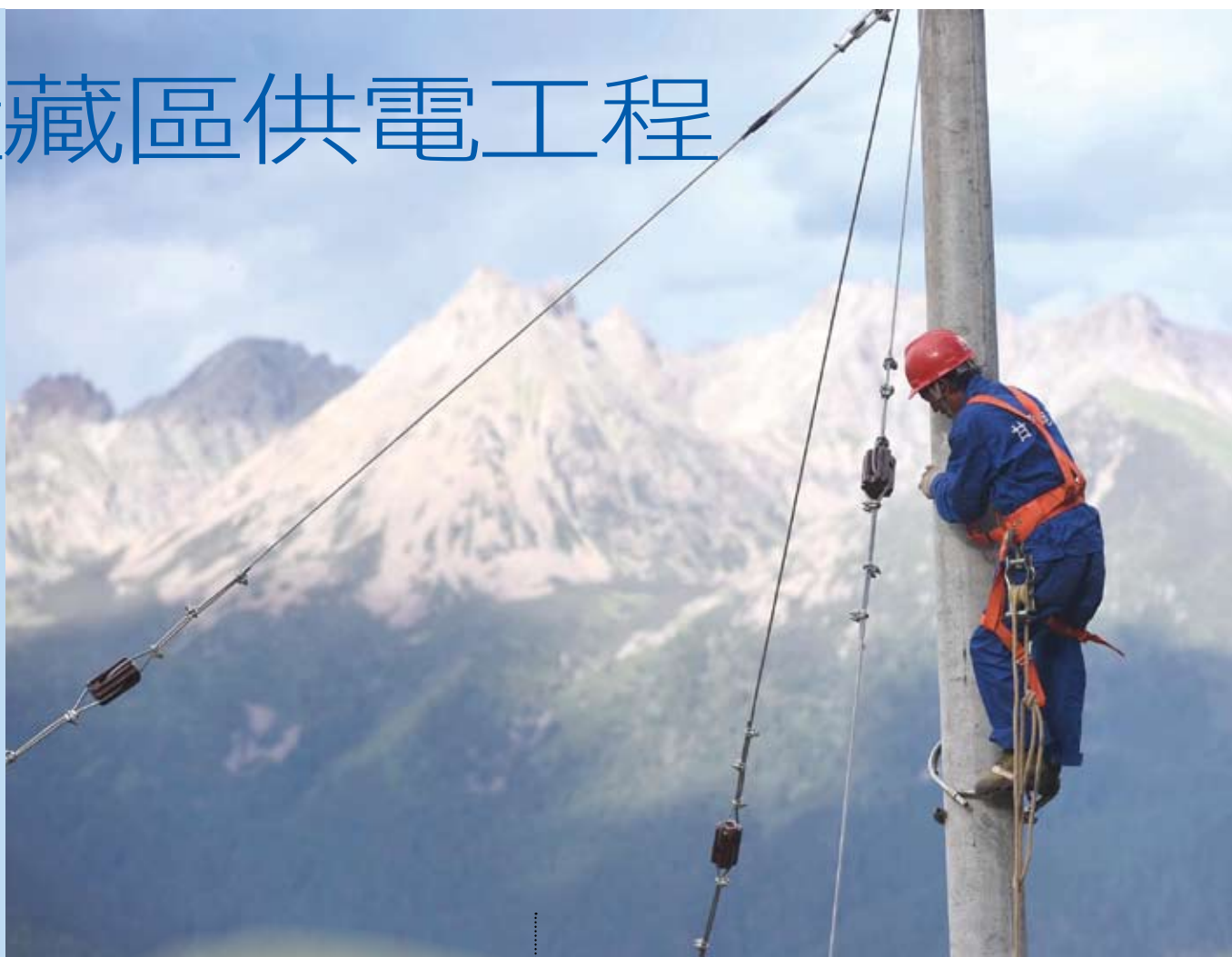
在海拔約3500公尺的四川甘孜藏族自治州，電力工作人員進行登杆作業。
