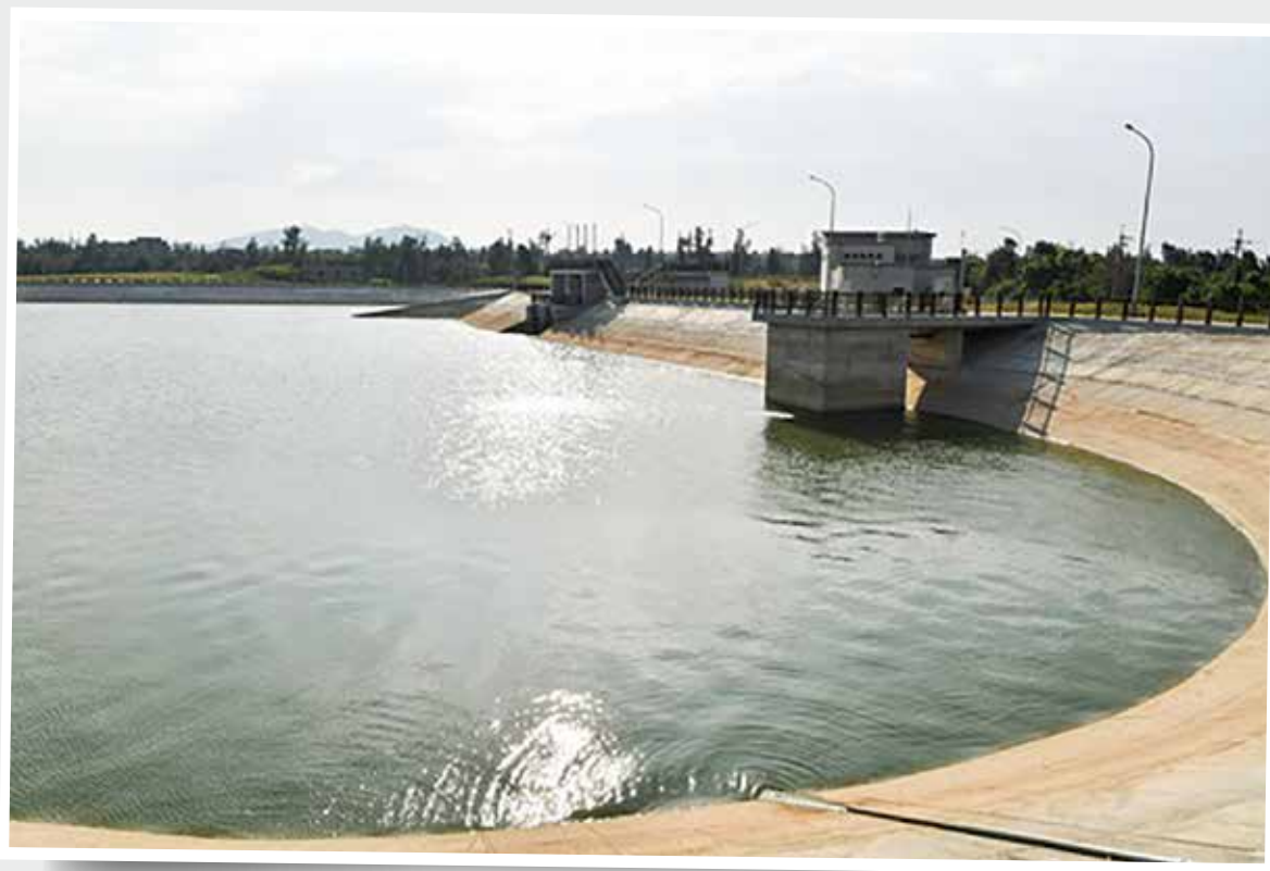
▲金門縣田埔水庫旁的受水池。
